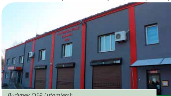
Budynek OSP Lutomiersk
