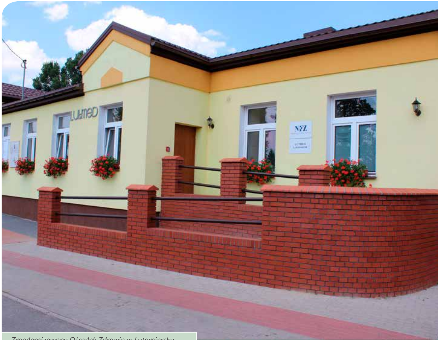
Zmodernizowany Ośrodek Zdrowia w Lutomiersku
