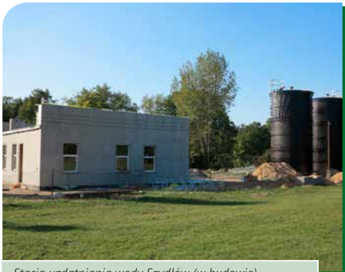
Stacja uzdatniania wody Szydłów (w budowie)
